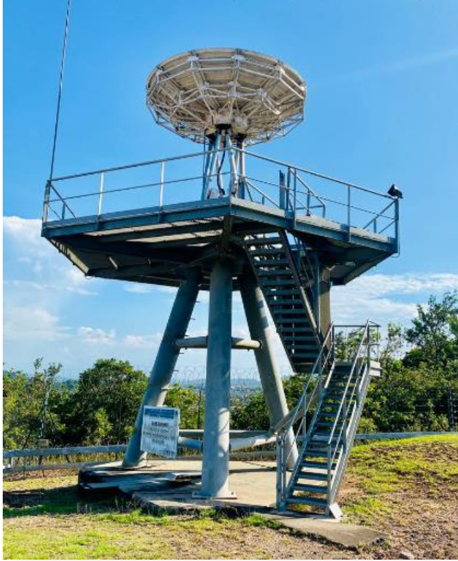
Antenne de reception bande X de type Cassegrain (4.5 m diamètre)
